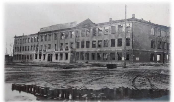
Разрушенное здание 1-й Сталинской школы (18-й средней школы)
